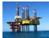
SAIPEM - Perro Negro 2 & 3 Offshore platform: ECOMAR 120 STP System
